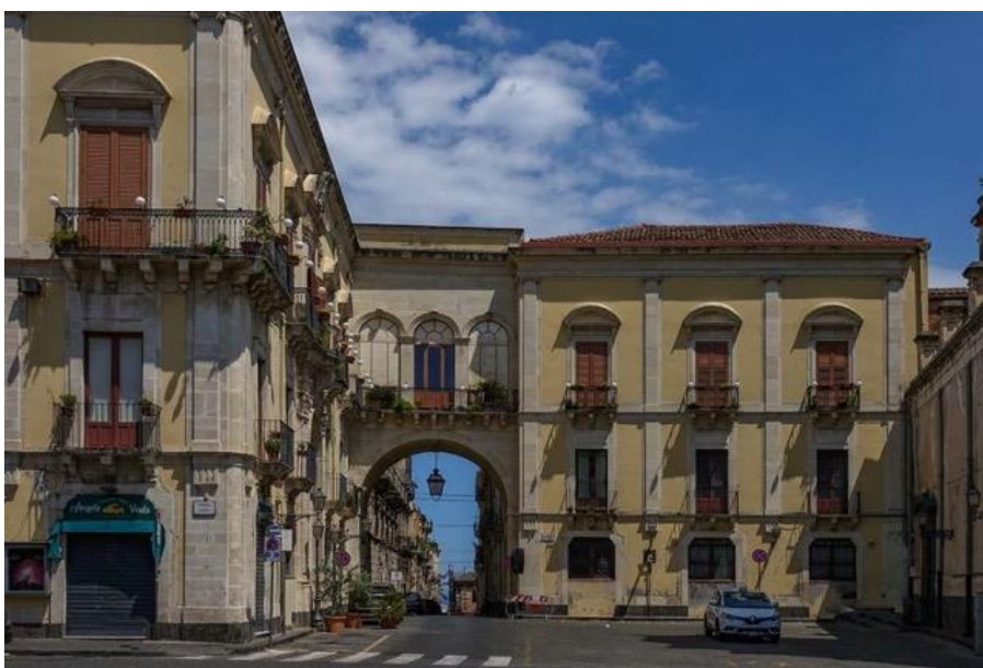
Largo Giovanni XXIII, adiacente al lato nord della Cattedrale. L'arco lega insieme la chiesa con la residenza del Vescovo e gli uffici di Curia.
